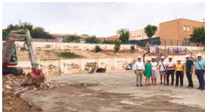
Inicio de las obras del comedor Colegio Virgen del Río
