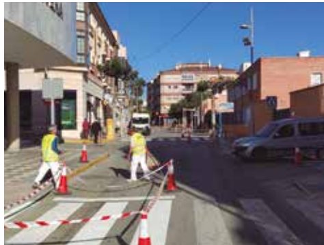
Mejoras, Pintura de paso de peatones y señalización vial.
