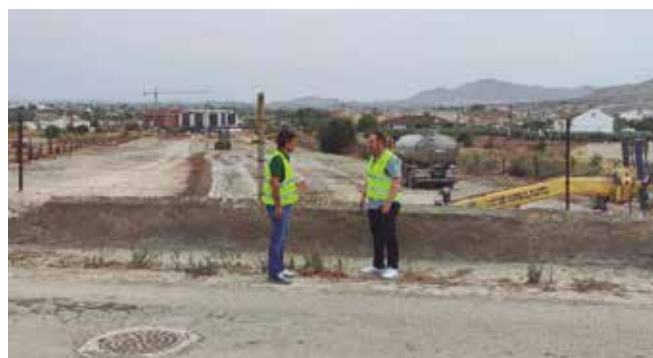
Obras acceso Hospital
