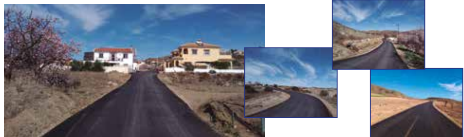
Asfaltado de caminos rurales, Camino Los López, en La Loma y en Las Piedras
