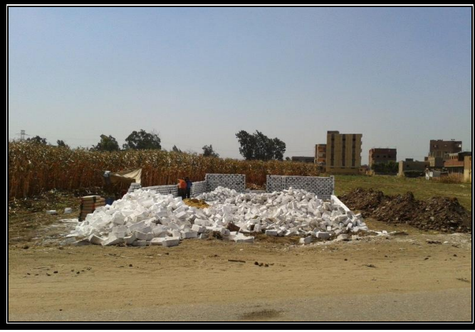
صورة رقم (١٢) توضح مرحلة البناء على الأرض الزراعية
