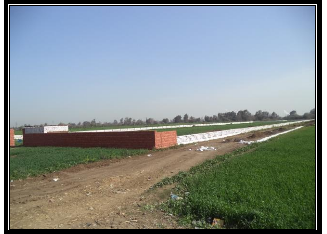
صورة رقم (٩) توضح تصوير المساحة المراد البناء عليها
