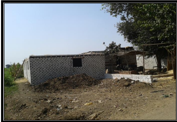
صورة(٥٢)توضح مبنى لإيواء الحيوانات بطه شبرا ٢٠١٤/١/٢٥
