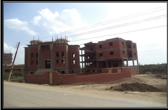
صورة (٣٢) توضح أكثر من نمط للإستخدام (منزل -مسجد) متعدد
