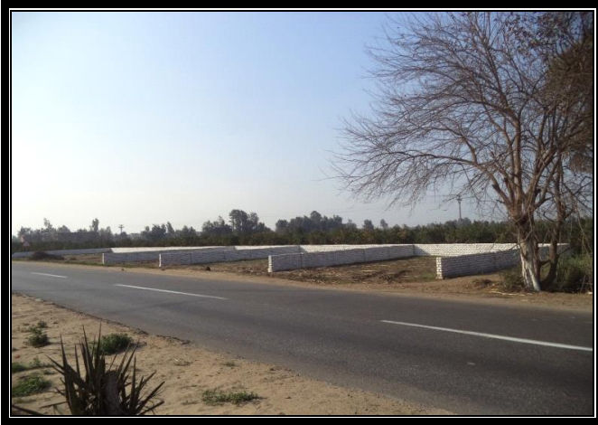
صورة رقم (١٠) توضح تصوير المساحة المراد البناء عليها
