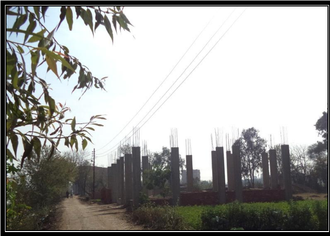
صورة رقم (١٤) توضح مرحلة بناء الأعمدة الخرسانية
