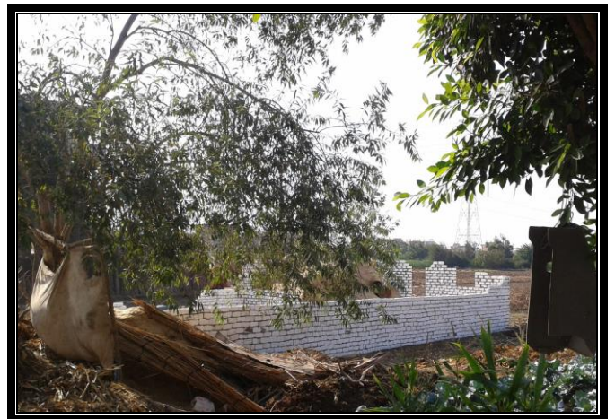
صورة(٥١)توضح مبنى لتخزين اعلاف الحيوانات كفر عبده ٢٠١٤/١/٢٥
