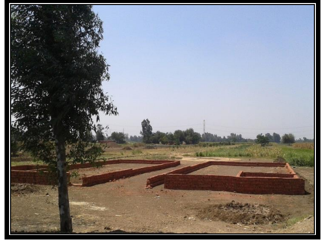
صورة رقم (٧) توضح تصوير المساحة المراد البناء عليها
