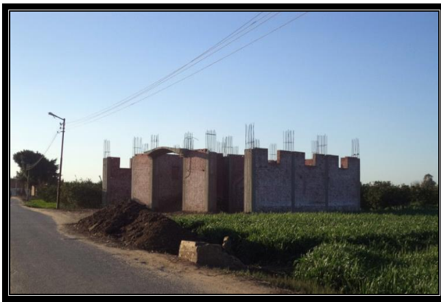
صورة رقم (٢٠) توضح محلات تحت الانشاء على الطرق الرئيسية
