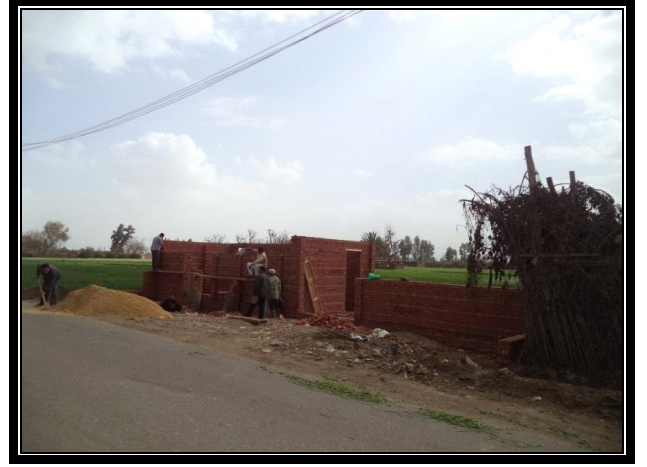
صورة رقم (١١) توضح مرحلة البناء على الأرض الزراعية
