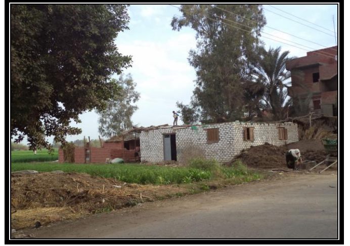
صورة (٥٣) توضح مبنى لإيواء الحيوانات بطه شبرا ٢٥/١/٢٠١٤
